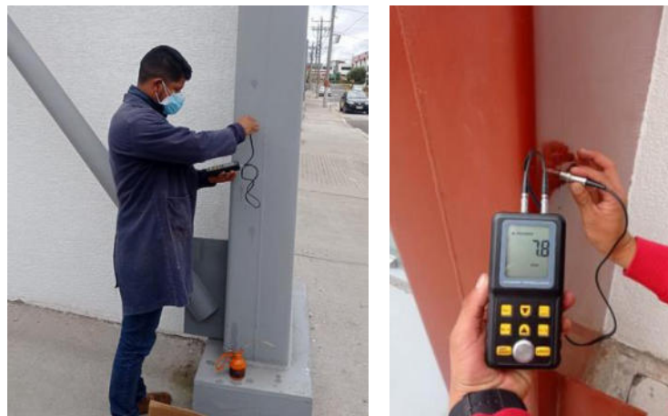
Figura 46: Medición de espesores mediante el medidor de espesores ultrasónico
