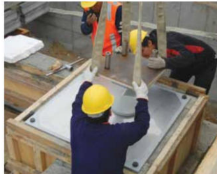
Figura 21: Apoyo deslizante plano.
