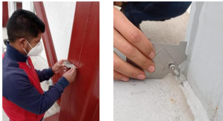
Figura 50: Medición del cordón de soldadura
