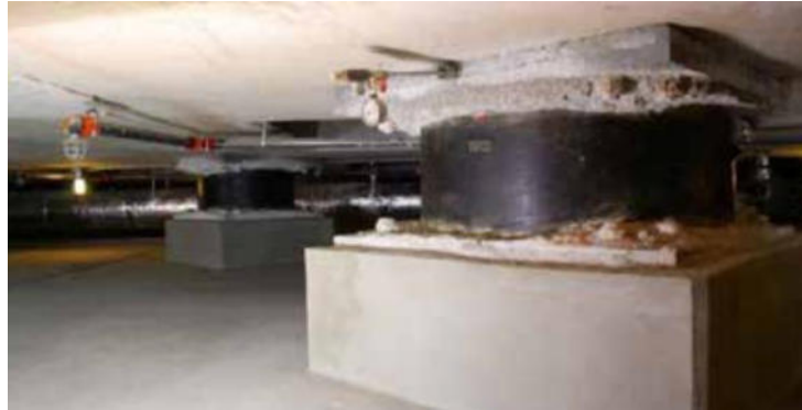
Figura 16: Aislador sísmico de goma
