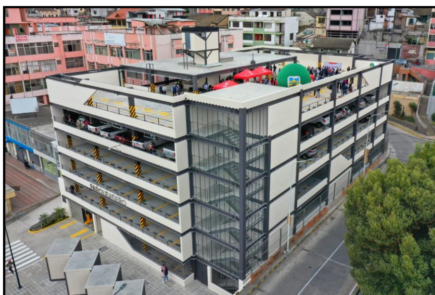
Gráfico 15: Vista en elevación de la edificación en estudio Muestra 1.
