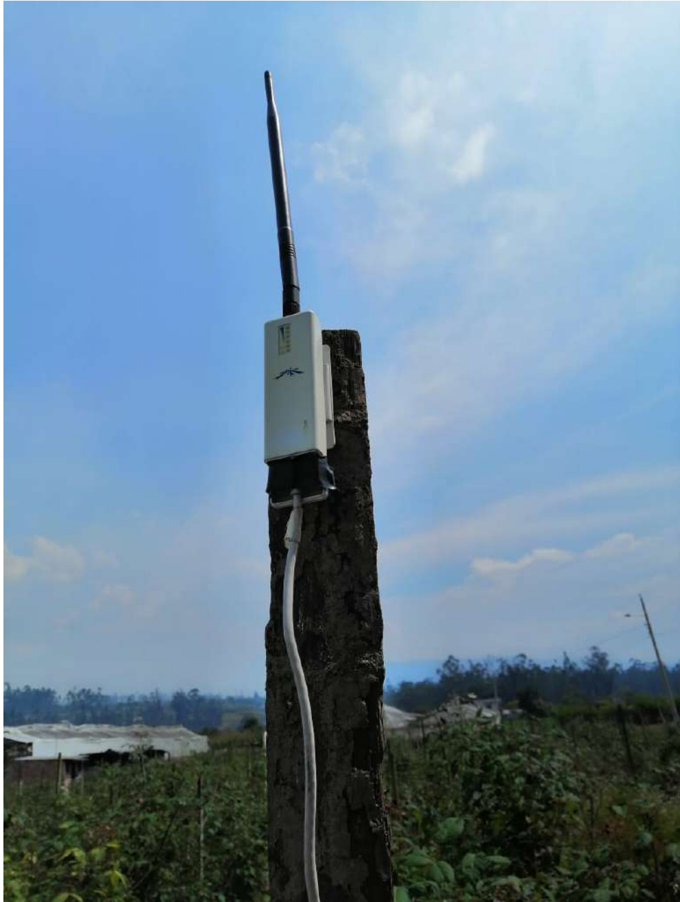
Figura 3: Instalación de la antena inalámbrica para los nodos sensores
