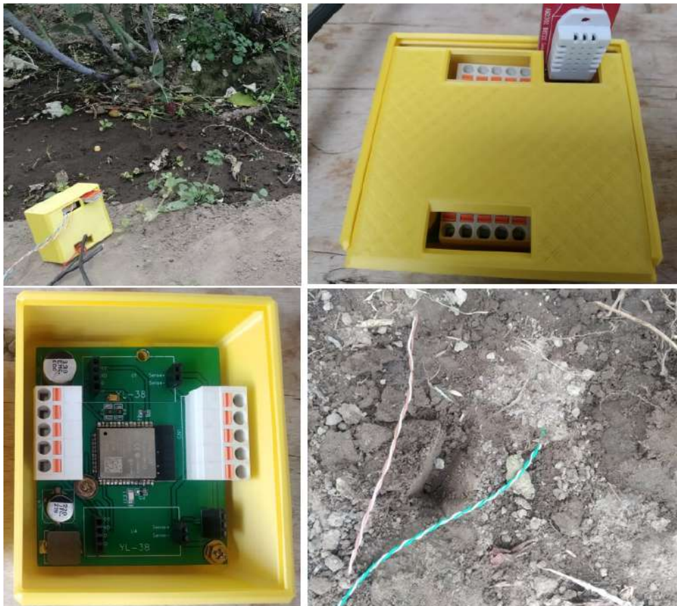
Figura 3.24: Instalación del nodo de sensorización
