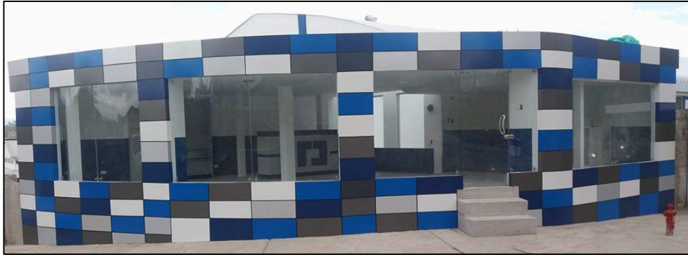
Figura 11. Vidrio estructural usado en ventanas de fachada Fuente: Autor
