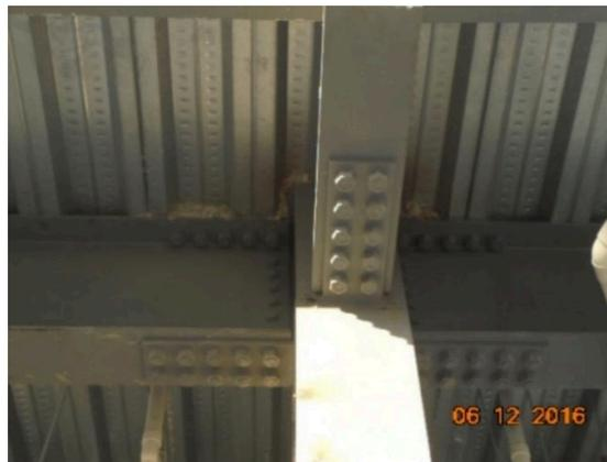
Figura 13. La placa horizontal posee un ancho menor al de la viga [19].
