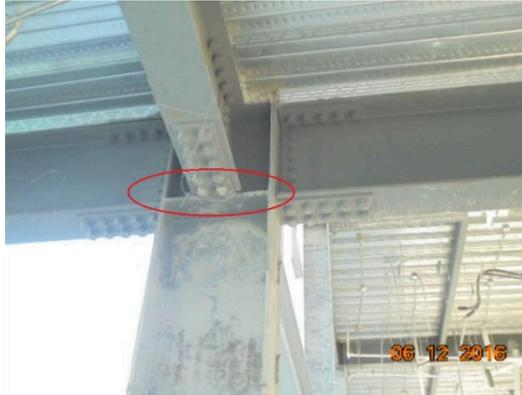
Figura 12. Separación de 2mm desde la viga al nudo en la Conexión BFP [19].
