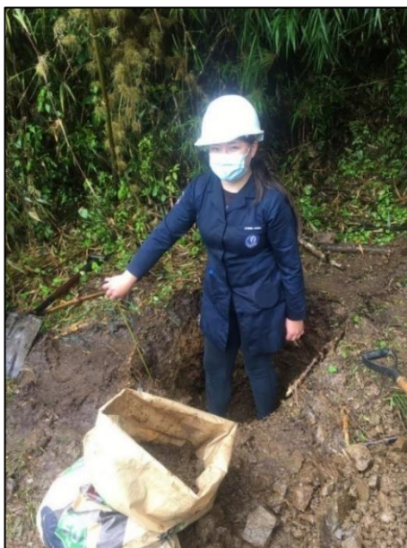
Fig. 18: Pozo a cielo abierto
