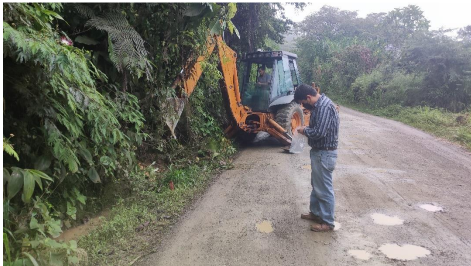
Limpieza y excavación de la ABS. 2+000
