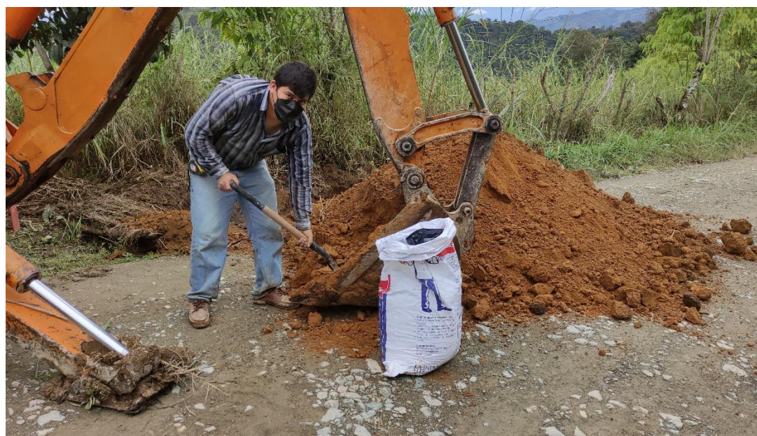
Toma de muestra de Sub-Rasante a -1.50m de la ABS. 7+000
