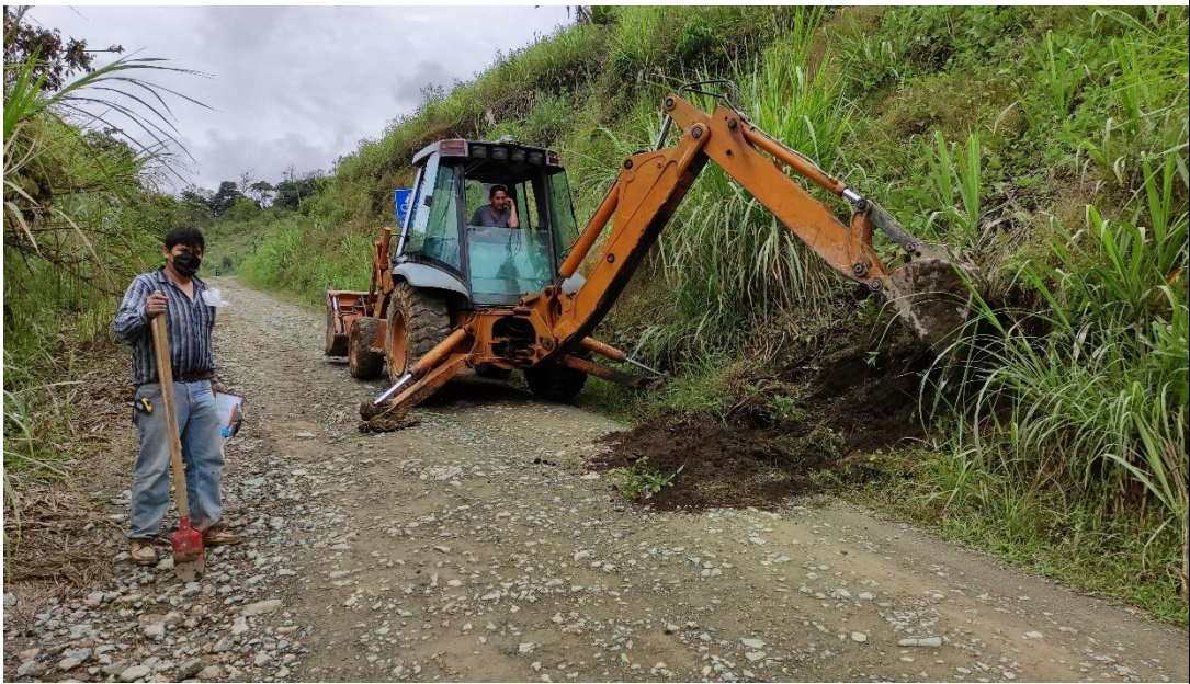
Limpeza y excavación de la ABS. 6+000
