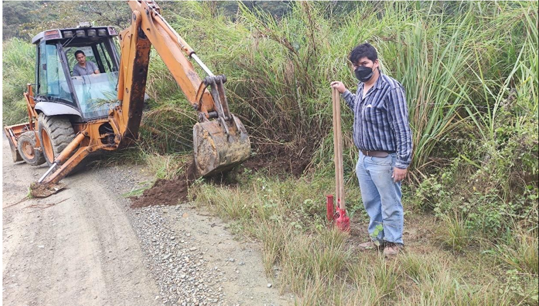
Limpieza y excavación de la ABS. 3+000
