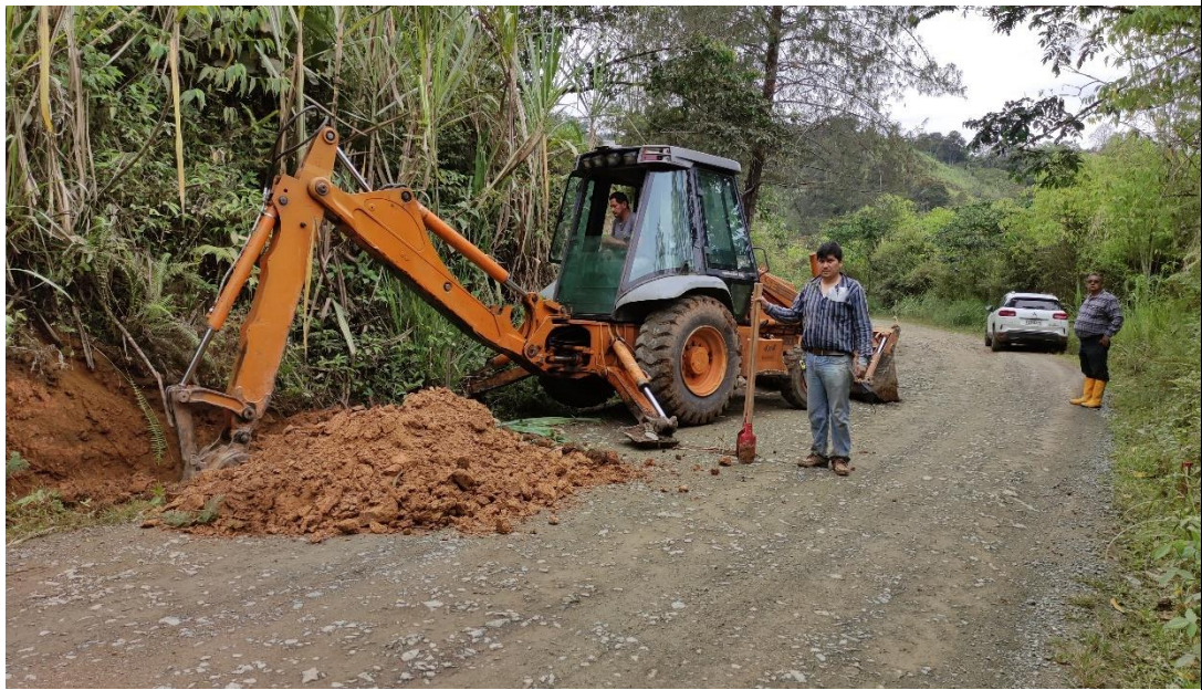
Limpieza y excavación de la ABS. 8+000
