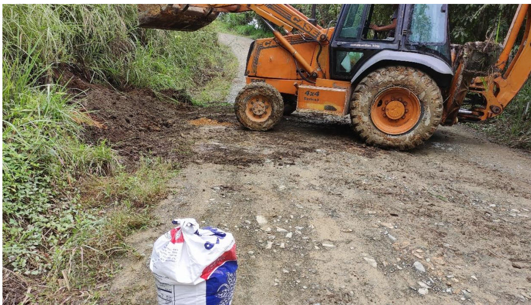
Devolución de la tierra a su excavación después de la toma de muestra de Sub-Rasante a -1.50m de la ABS. 5+000
