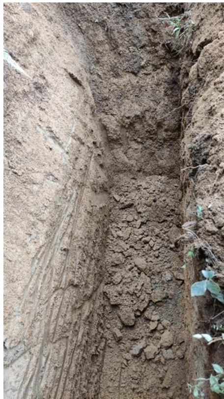
Toma de muestra de Sub-Rasante a -1.50m de la ABS. 9+000
