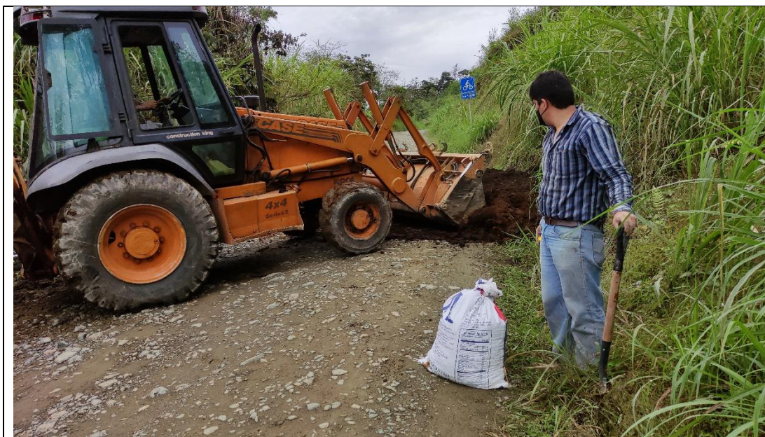
Devolución de la tierra a su excavación después de la toma de muestra de Sub-Rasante a -1.50m de la ABS. 6+000
