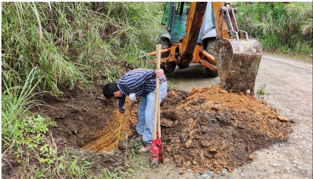
Comprobacion de nivel de -1.50m para extracción de la muestra de la Sub-Rasante de la ABS. 4+000
