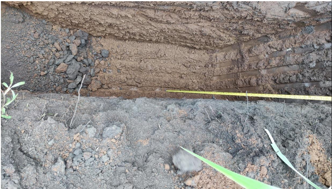
Comprobacion de nivel de -1.50m para extracción de la muestra de la Sub-Rasante de la ABS. 6+000
