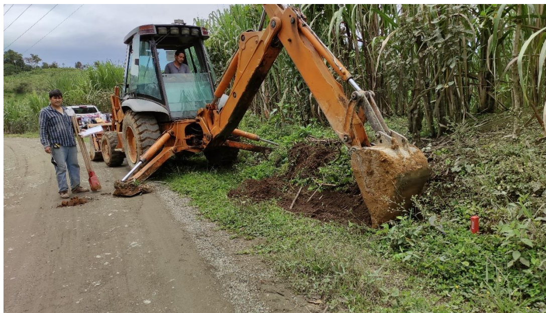
Limpieza y excavación de la ABS. 10+000
