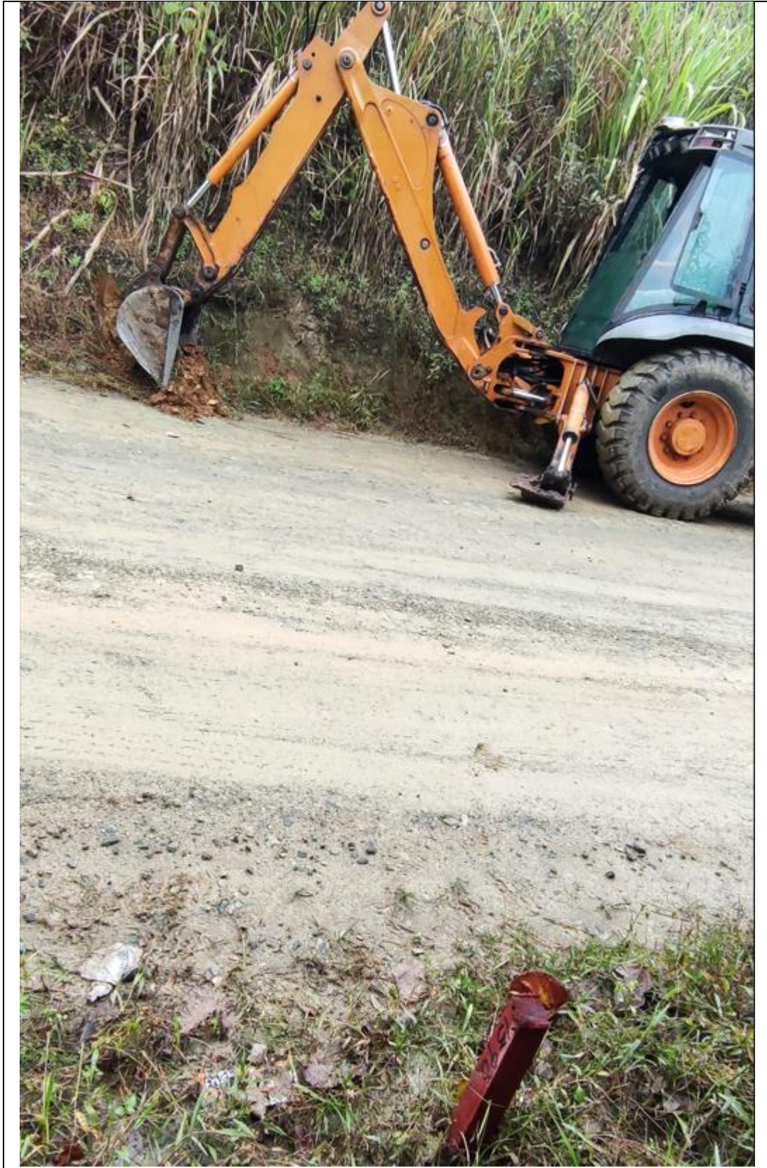
Limpieza y excavación de la ABS 1+000
