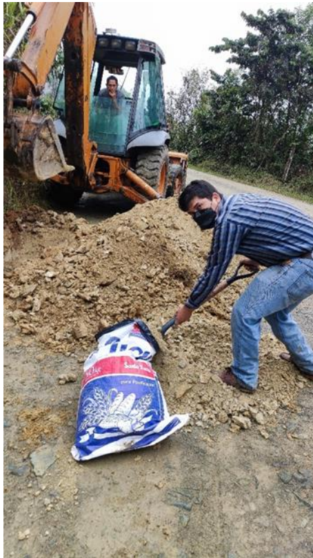
Toma de muestra de Sub-Rasante a -1.50m de la ABS. 1+000
