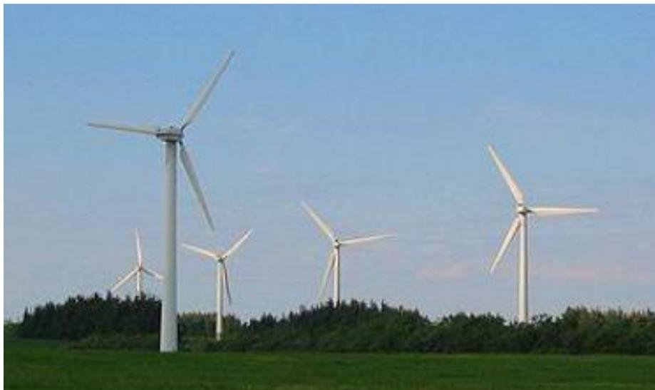
**Figura 1.2:** Aerogenerador tipo HAWT [9].
