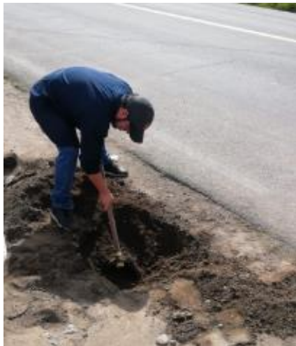
Calicata y extracción de material
