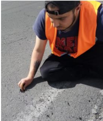
Toma de temperatura de la capa de rodadura
