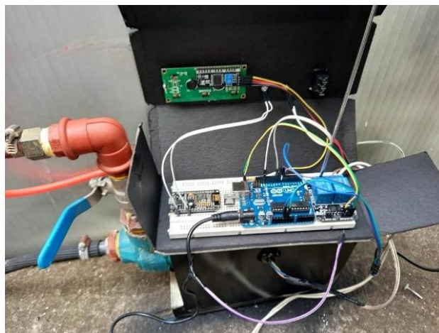
Figura 28.- Armado del circuito de control y automatización de la cabina. Elaborado por: El investigador.
