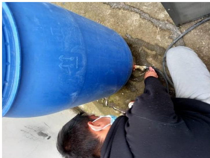
Figura 14.- Acople del tanque a la bomba de agua. Elaborado por: El investigador.
