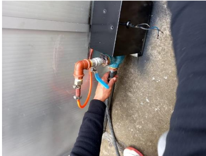
Figura 13.- Colocación de la bomba de agua en la cabina. Elaborado por: El investigador.
