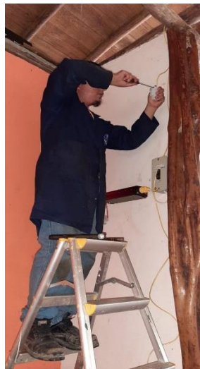
Figura 46: Colocación de un fusible entre los paneles y el regulador solar
