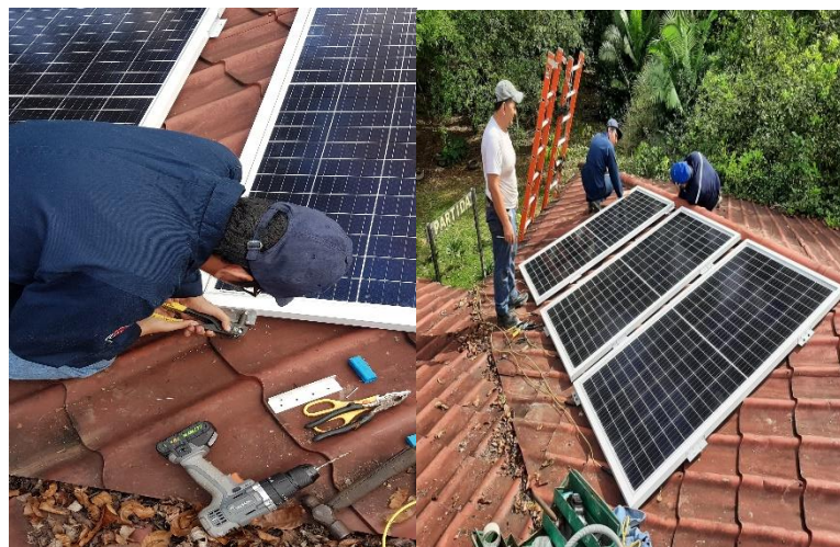
Figura 44: Anclaje de los paneles solares al techo de la vivienda
