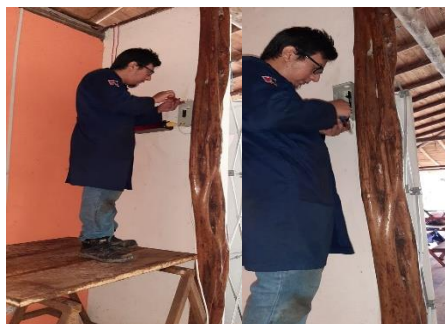
Figura 54: Instalación del breaker entre el inversor y las cargas
