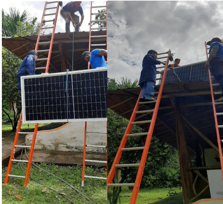
Figura 43: Subida de los paneles solares
