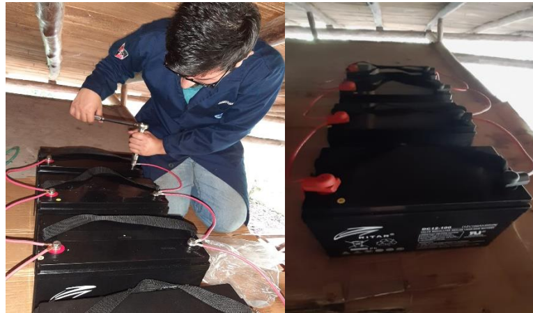
Figura 47: Conexión en paralelo de las baterías
