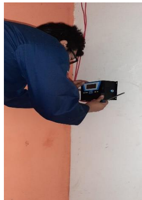
Figura 51: Colocación del regulador solar a la pared
