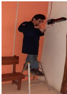
Figura 53: Instalación del inversor del voltaje con conexión al regulador solar
