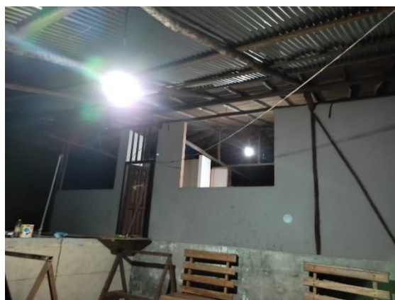
Figura 73: Prueba de funcionamiento de las iluminarias en la noche
