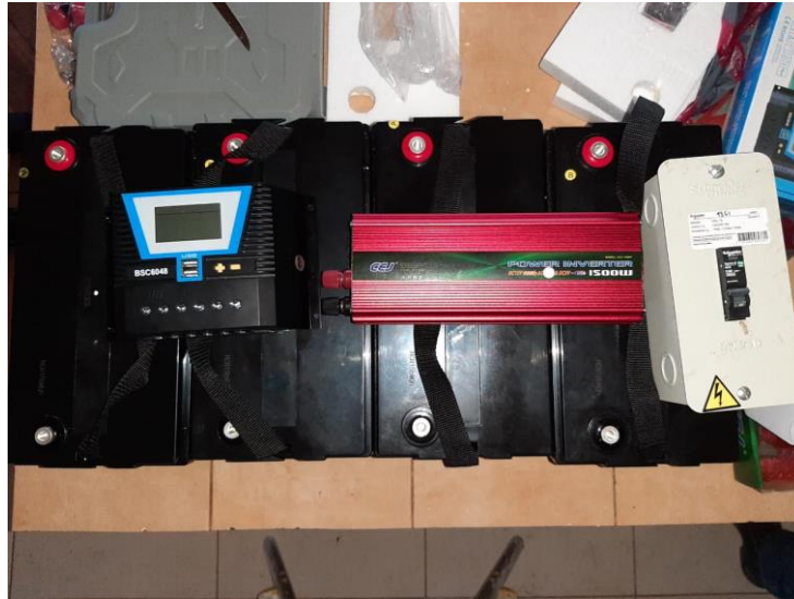
Figura 41: Equipos ya trasladados en la casa-comedor para su instalación
