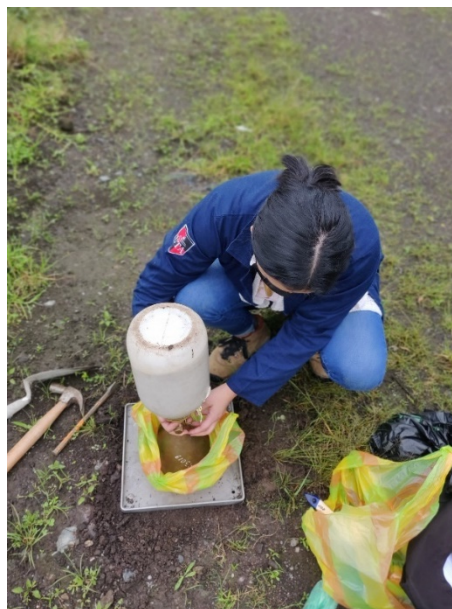
Figura 32 Colocación del cono y arena de Ottawa
