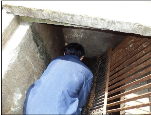
Figura 11 Toma de caudales de agua residual de ingreso de la planta de Puñachizag
