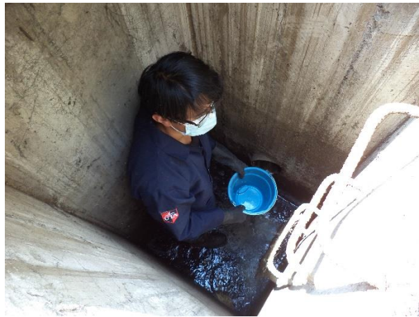
Figura 39 Obtención de caudales del agua tratada de la PTAR.
