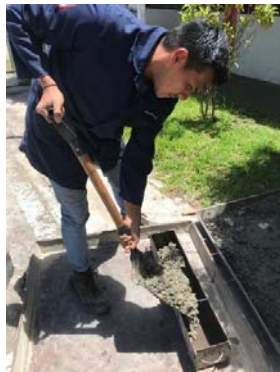
Ilustración 29. Elaboración de vigas para flexión
