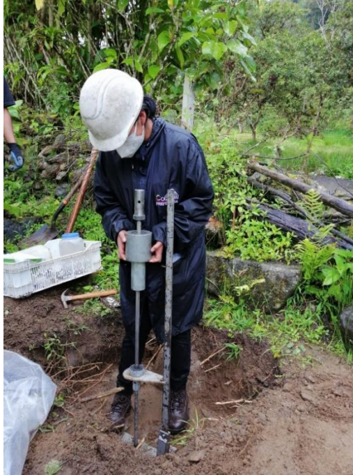
Figura 20. Ensayo DCP, M2-Río Blanco.
