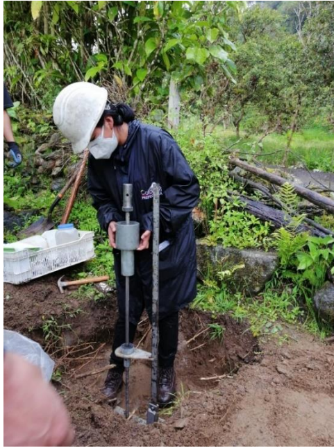
Figura 66. Ejecución ensayo DCP- vía Río Blanco.
