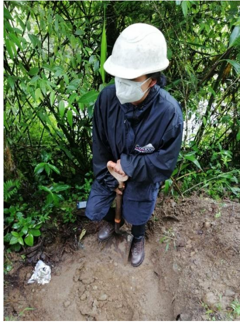
Figura 62. Excavación de suelo a un costado de la vía.
