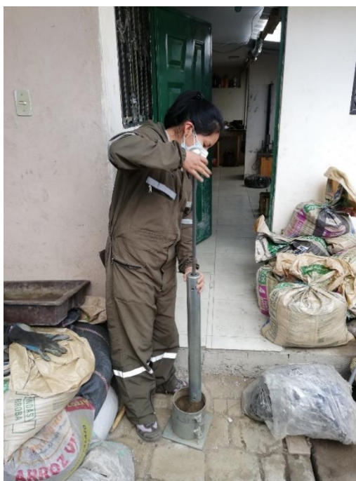
Figura 77. Compactación de suelo – última capa.
