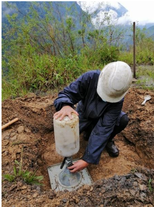
Figura 65. Ejecución del ensayo cono y arena.
