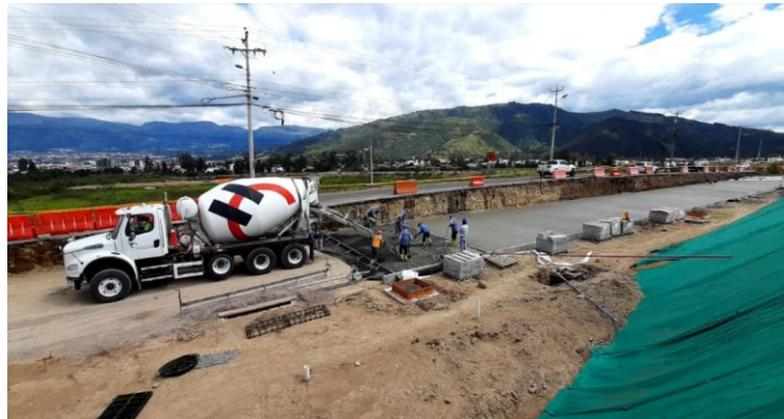
Figura 39 Descarga directa del camión mixer
