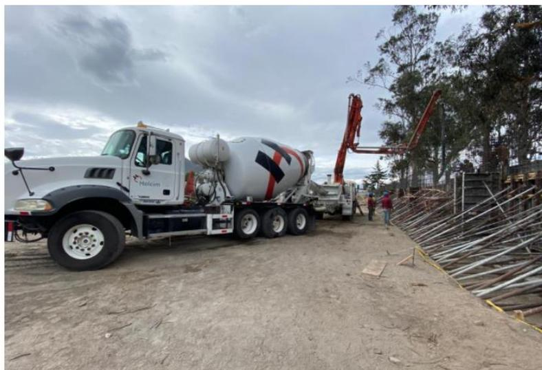
Figura 41 Descarga de concreto con bomba
