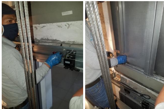
Figura 50. Ajuste de cabeceros y quicios de puertas de pisos. Elaboración propia.
