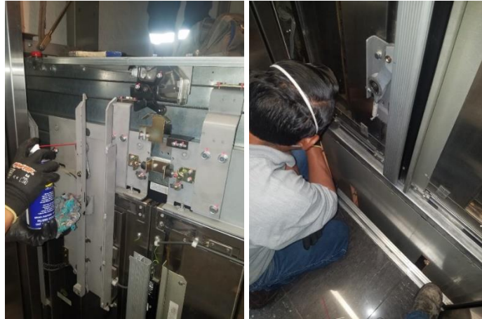
Figura 46. Instalación de puertas de cabina. Elaboración propia.
