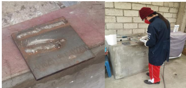
Figura 2-21. Aplicación de limpiador
