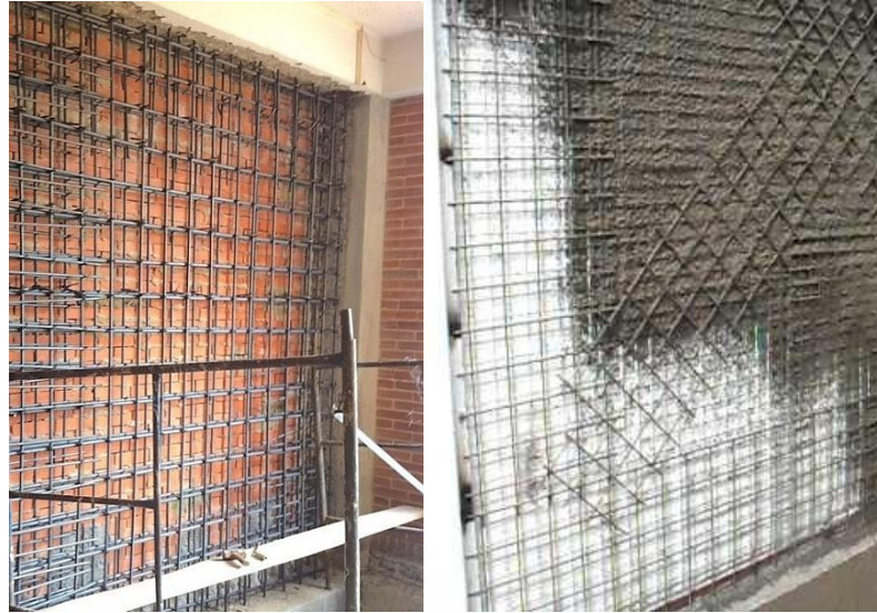
Figura 34: Enchapados de paredes de mampostería
