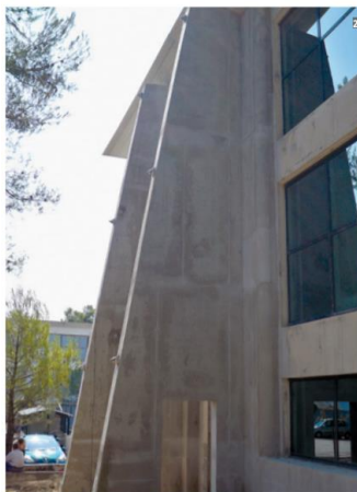
Figura 40: Contrafuertes exteriores en edificios existentes
