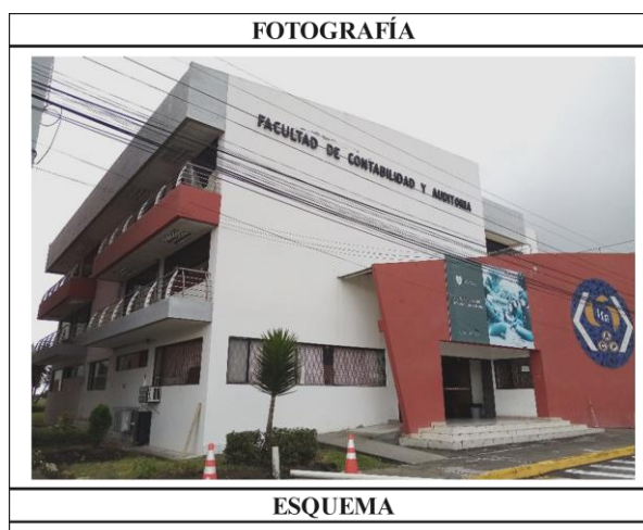
Figura 63: Paso 1, Fotografía, Inspección Visual Rápida FEMA 154
