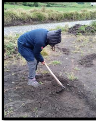
Figura 75: Escavando el pozo a cielo abierto
