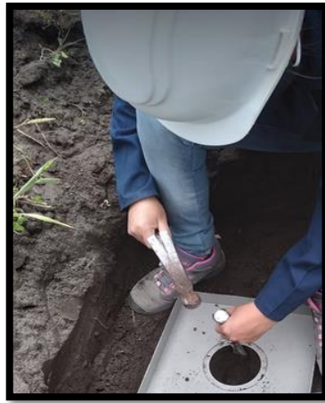
Figura 78: Excavando con ayuda de cincel
