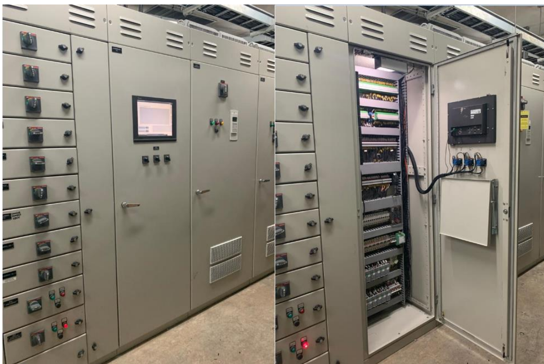
Figura 61. Montaje de la HMI en el tablero de control del NSAE
