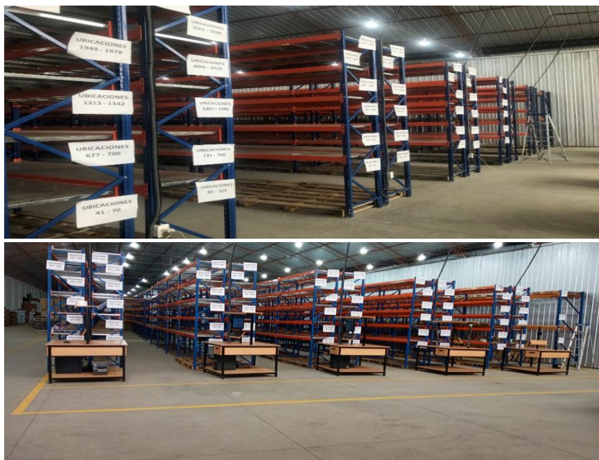
Figura 4-22. Implementación de racks de carga semi pesada y de equipos para proyecto Picking Santa Rosa TSA
