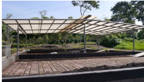
Figura 23. Ejemplo de Lecho de Secado de Lodos
