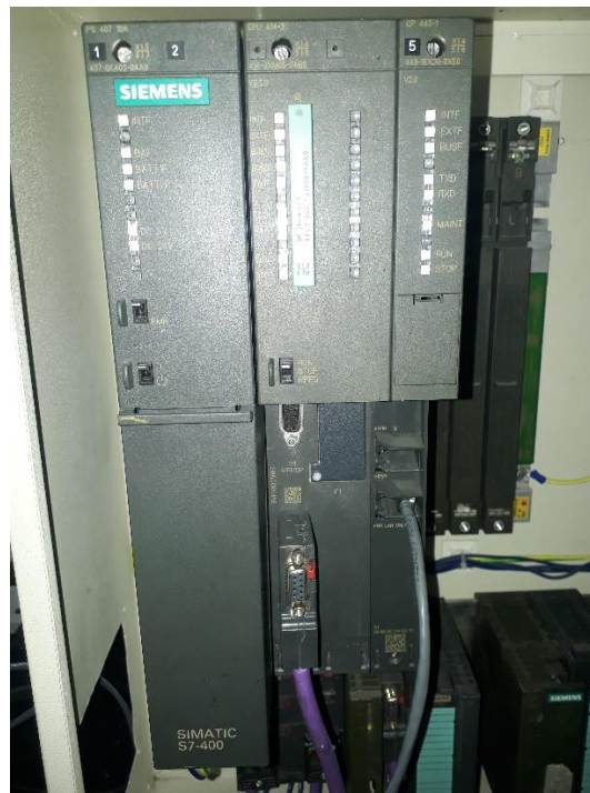
. Fig. 4. 2. Ubicación del S7-400 en el bastidor.
