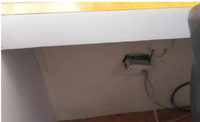
Figura 65. Interruptor en mal estado.
