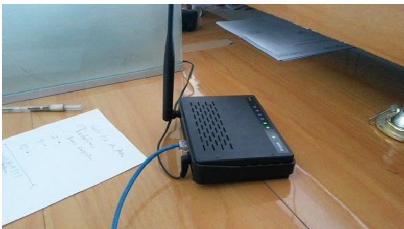
Figura 55. Hardware junto a las instalaciones eléctricas
