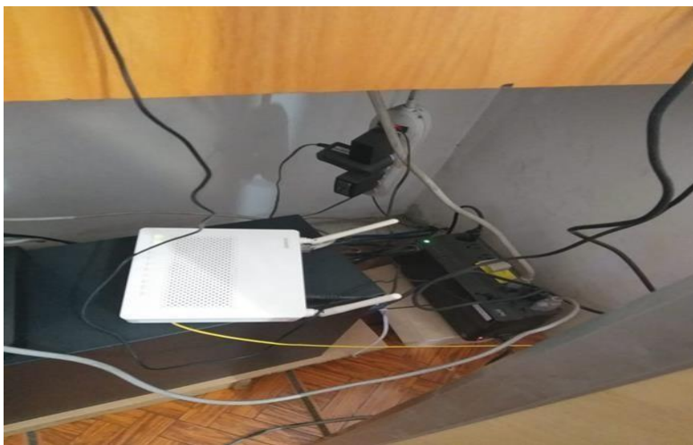
Figura 62. Cables sin su respectivo canaletas en el área de Sistemas
