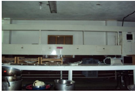
TUNEL DE SECADO
