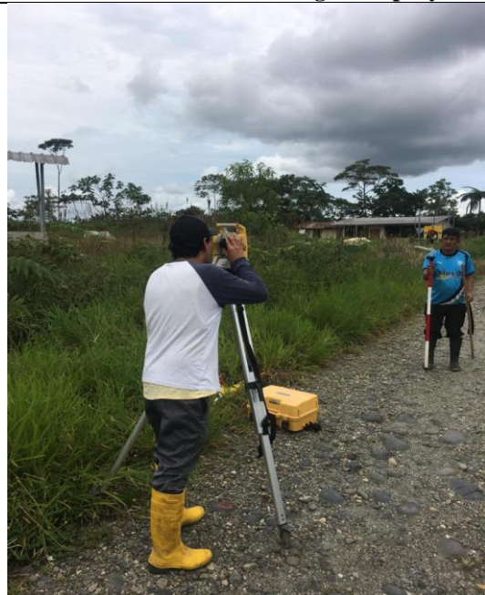
Foto 3.- Toma de puntos Topograficos.
