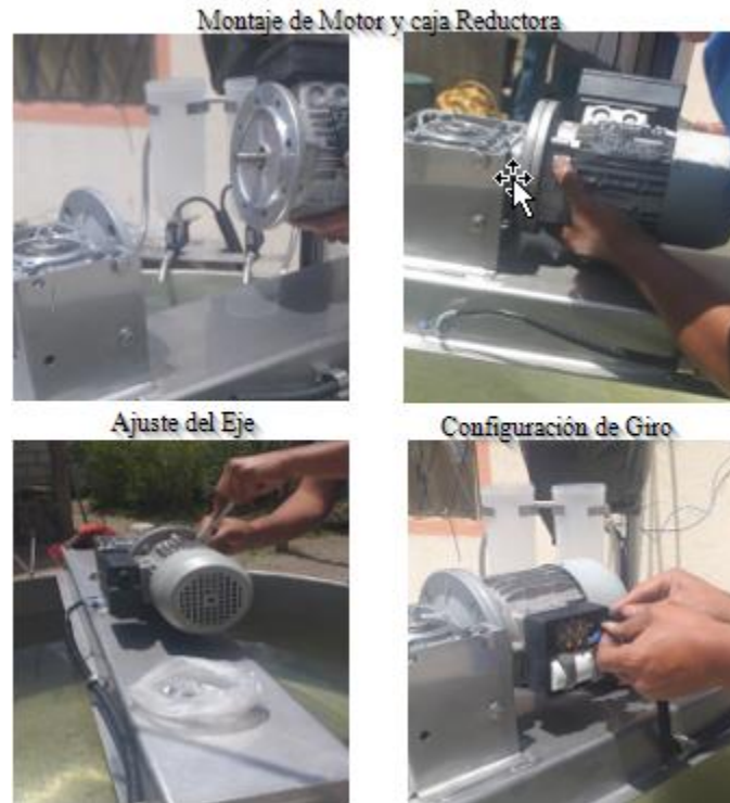
Figura 114. Montaje e instalación del motor agitador Elaborado por: El investigador
