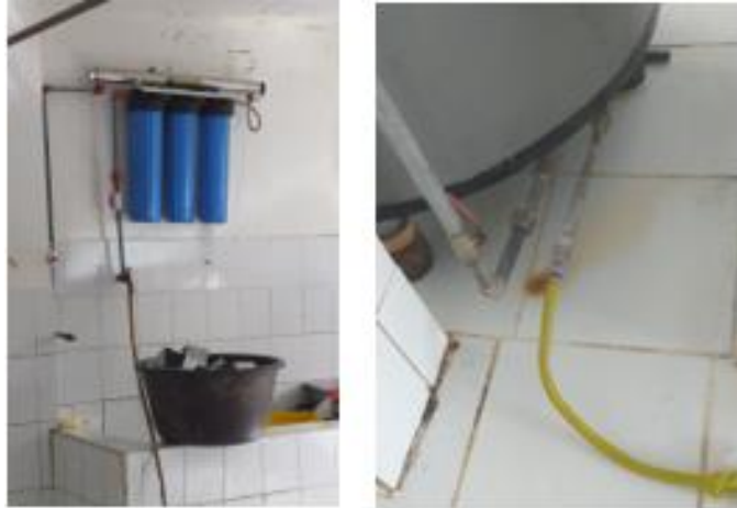
Figura 40. Ingreso y salida del sistema de enfriamiento de la marmita
