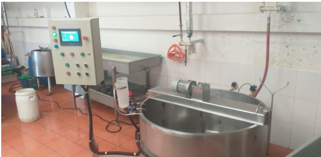
Figura 176. Pruebas de funcionamiento instalación
