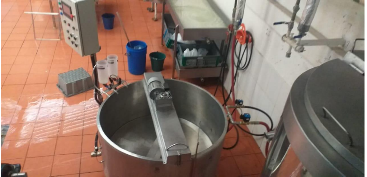
Figura 174. Instalación de la maquina
