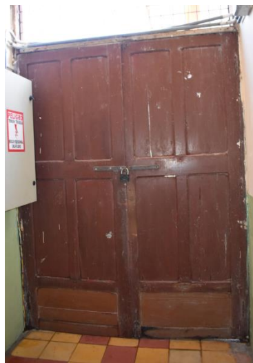
Imagen 32: Puerta lateral derecha de la primera planta
