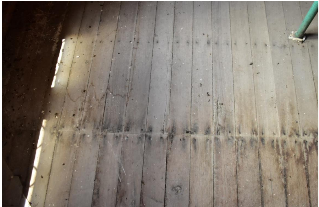
Imagen 33: Piso de madera de la segunda planta
