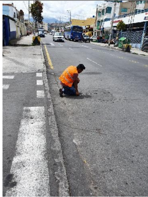
Medición de longitudes de las fallas
