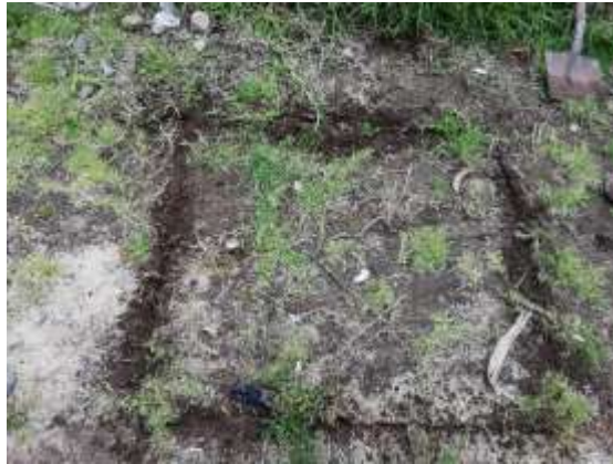
Figura 69. Señalamiento de la ubicación del pozo.
