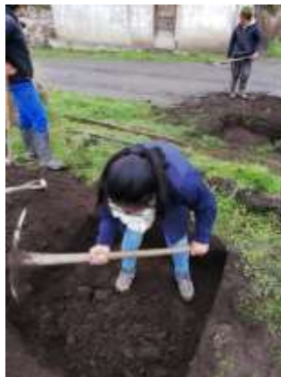
Figura 70. Excavación del pozo z cielo abierto
