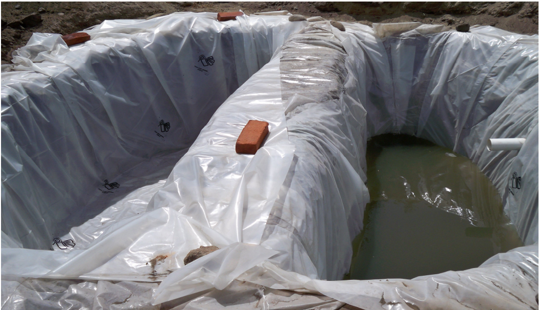
Imagen D-9. Llenado de estanque #1 con agua contaminada previa la colocación de lechuguín.
