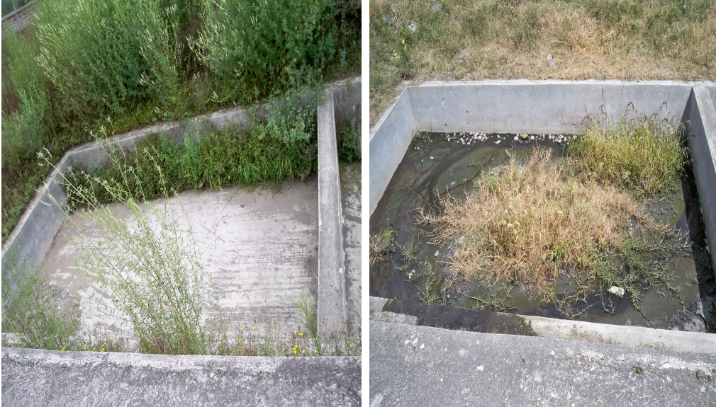
Imagen D-3. Fosa séptica colapsada por taponamiento en tubería anteriores debido al crecimiento abundante de maleza.
