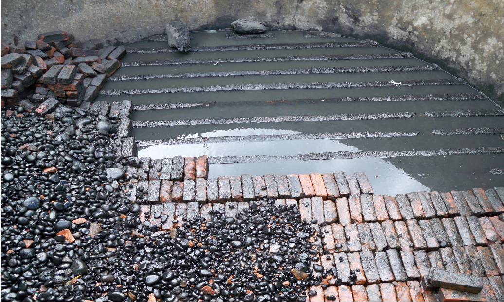
Imagen D-17. Vaciado de los estanques, una vez terminada la primera etapa, previo a su lavado.
