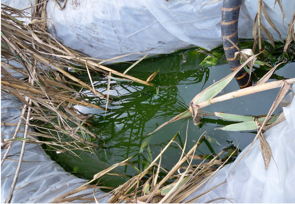
Imagen D-13. Caja de filtro en malas condiciones debido a la acumulación de lodo en las piedras, requiere limpieza.
