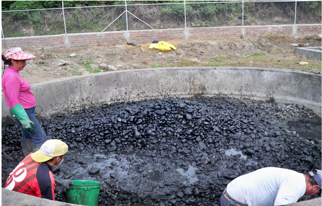
Imagen D-15 Lavado de las piedras de la caja filtro.
