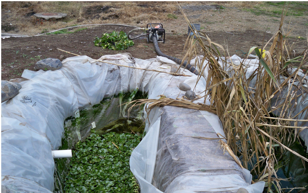
Imagen D-17. Vaciado de los estanques, una vez terminada la primera etapa, previo a su lavado.
