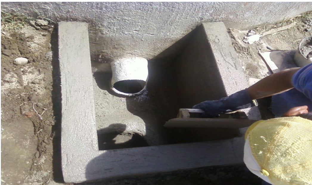
Imagen D-7. Vista interna de la caja de revisión construida para el control de ingreso de agua hacia los estanque vegetales.
