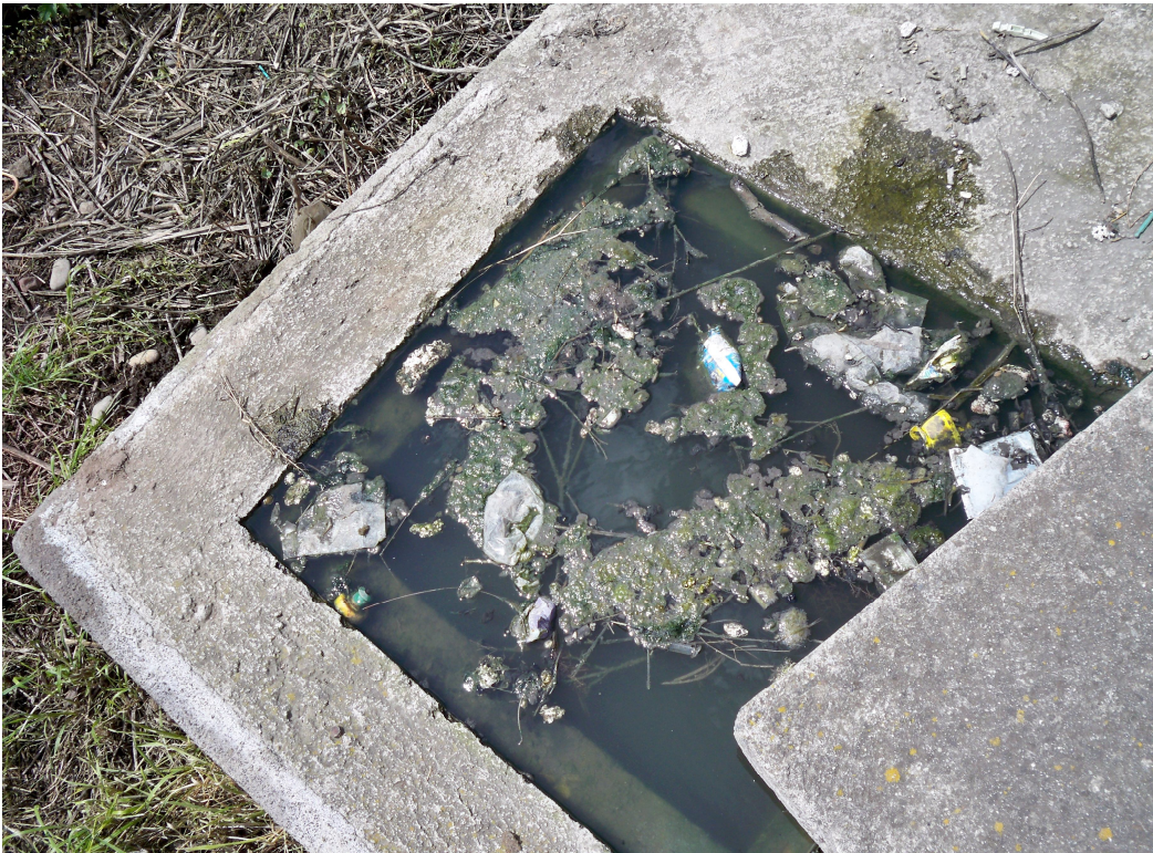
Imagen D-3. Fosa séptica colapsada por taponamiento en tubería anteriores debido al crecimiento abundante de maleza.
