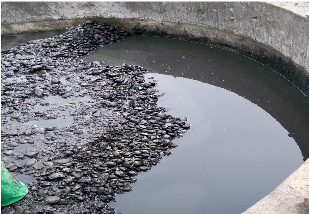
Imagen D-13. Caja de filtro en malas condiciones debido a la acumulación de lodo en las piedras, requiere limpieza.
