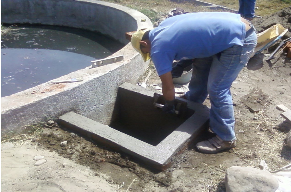
Imagen D-7. Vista interna de la caja de revisión construida para el control de ingreso de agua hacia los estanque vegetales.
