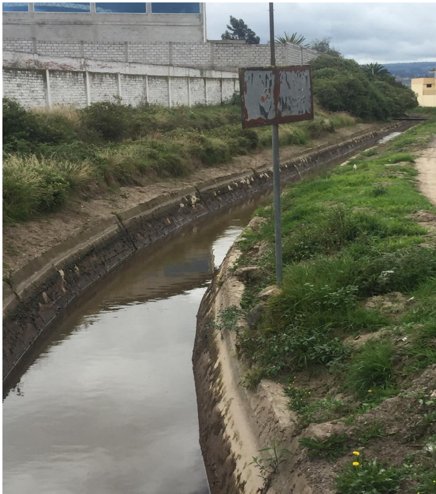
Figura 26 Canal de Regadío Fuente: La investigadora
