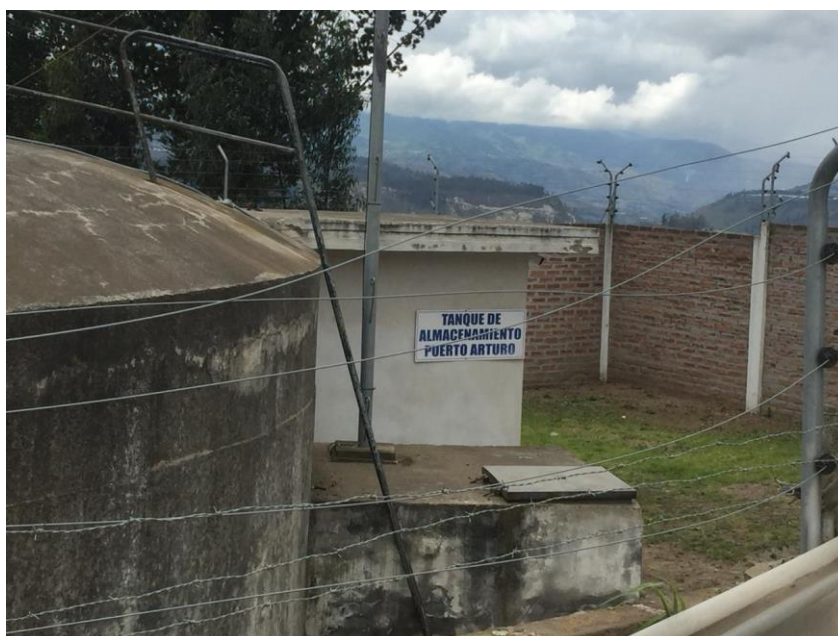
Figura 15 Tanque de almacenamiento Puerto Arturo Fuente: La investigadora
