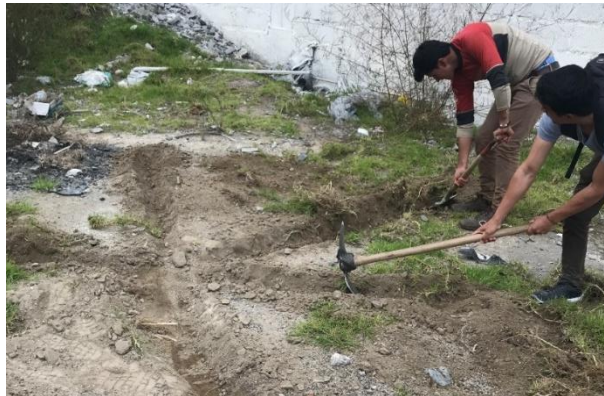
Figura 9: Limpieza de la capa vegetal
