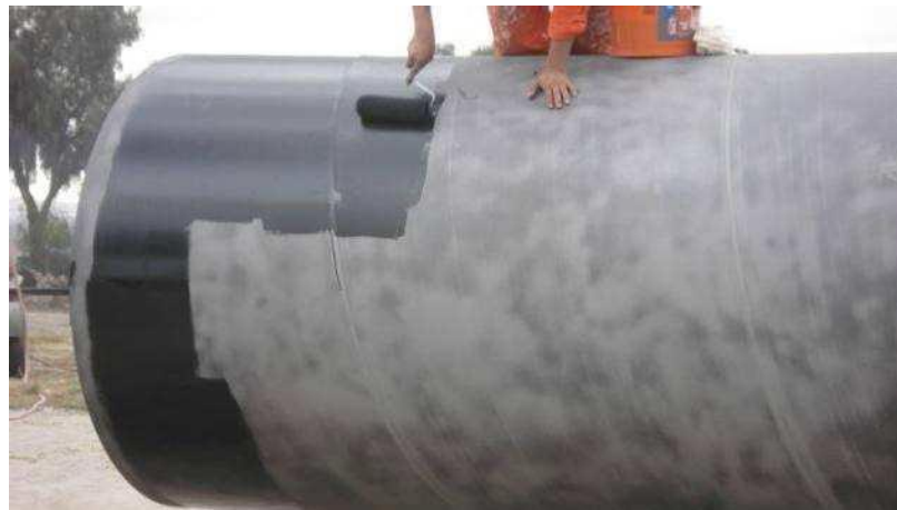
Figura 14. Aplicación de recubrimiento con rodillo. [19]
