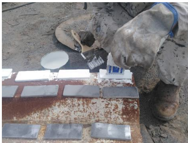
Figura 29. Verificación de espesores húmedos.
