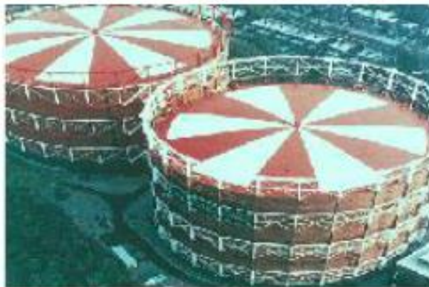
Figura 4. Efectos de la Corrosión – Apariencia. [15]
