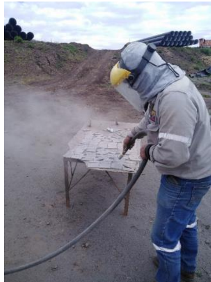
Figura 26. Limpieza Sandblasting.
