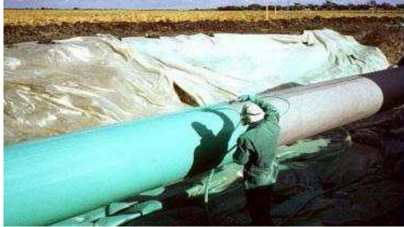
Figura 15. Aplicación de recubrimiento con pistola de pulverización. [19]
