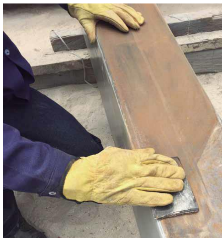
Figura 7. Limpieza SSPC-SP-2. [19]
