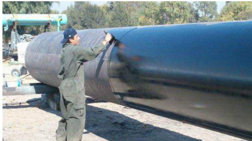
Figura 13. Aplicación del recubrimiento con brocha. [19]
