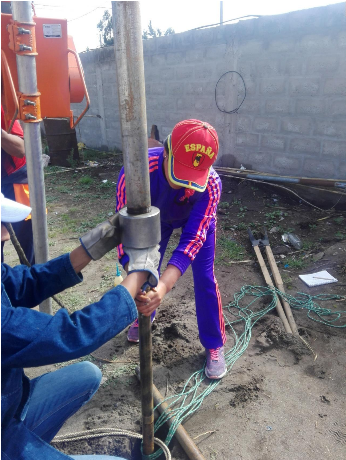
Fotografía 3: Ensayo de penetración estándar (SPT).
