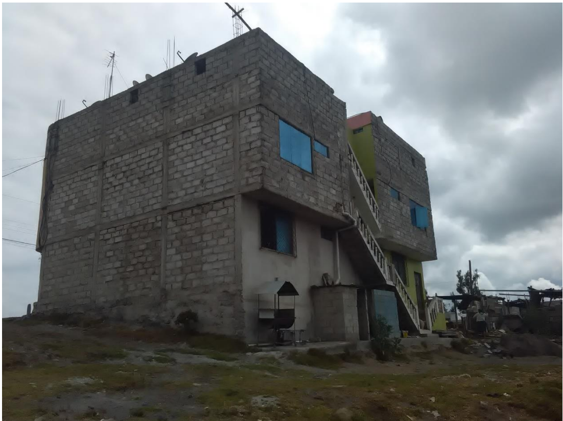
Fotografía 7: Estructura de 3 pisos ubicada en el lugar de estudio.
