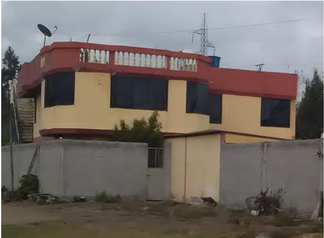
Fotografía 6: Estructura de 2 pisos ubicada en el lugar de estudio.
