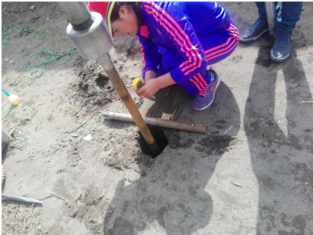
Fotografía 2: Ensayo de penetración estándar (SPT).
