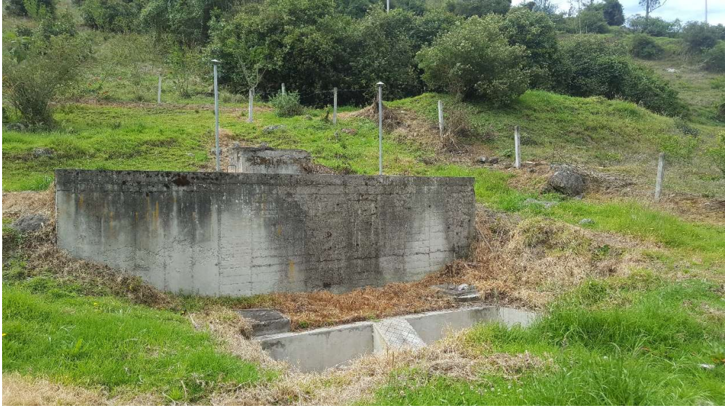
Figura 39 PTAR inicio de Proyecto
