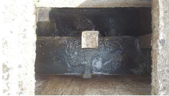
Figura 17 Desarenador PTAR
