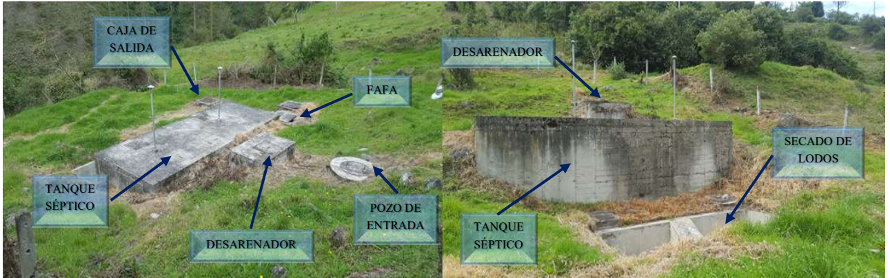
Figura 15 Estado actual de PTAR de la parroquia Poatug
