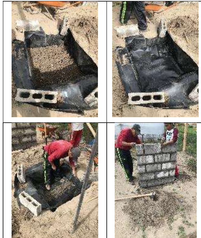
Anexo 3: Proceso Constructivo del muro 3.
