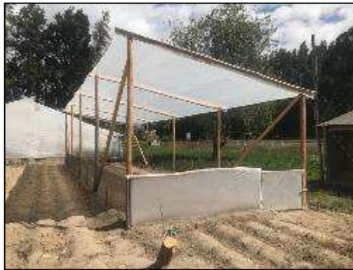
Figura 11: Estructura terminada. Fuente: Alejandro Campaña
