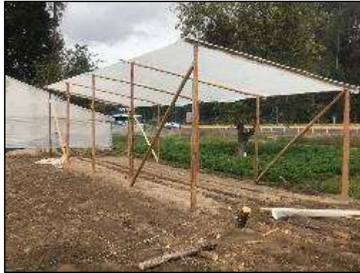
Figura 10: Colocación de cubierta de plástico en la estructura. Fuente: Alejandro Campaña
