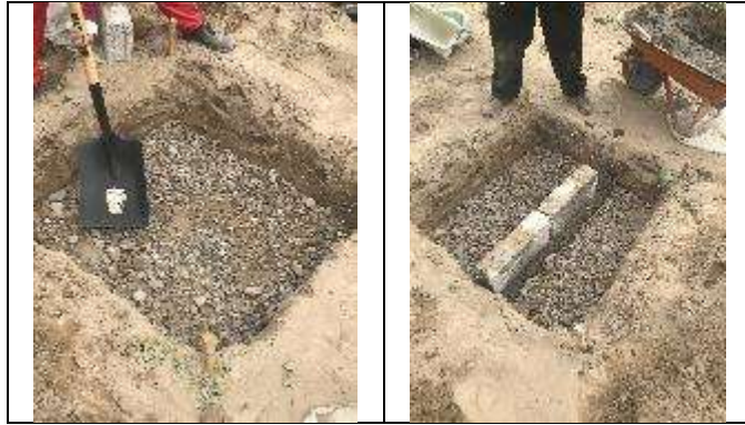
Anexo 6: Proceso Constructivo del muro 6
