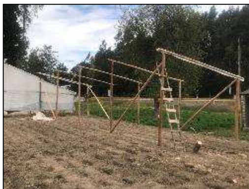
Figura 9: Construcción de Pórticos de Madera. Fuente: Alejandro Campaña
