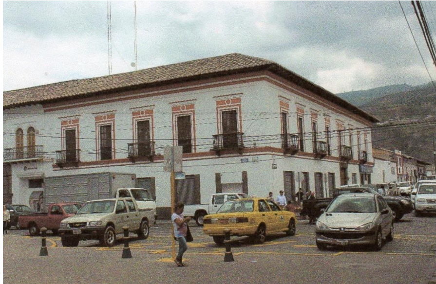
Figura 25.- Estado del inmueble antes de la intervención (Ruiz + Ruiz, 2018).
