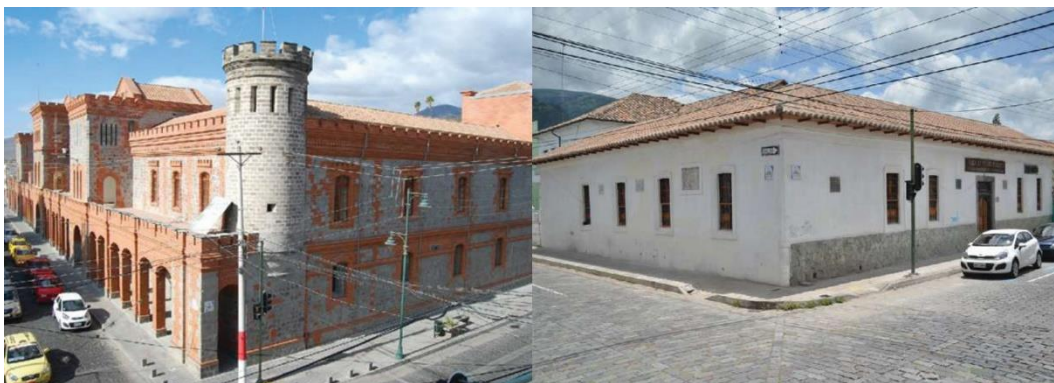
Figura 14.- Inmuebles públicos (Unidad de Patrimonio, 2017).
