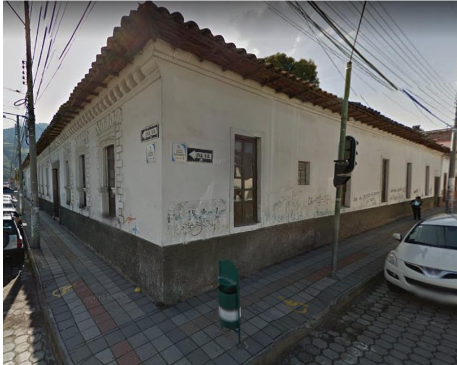
Figura 16.- Estado del inmueble antes de la intervención (Google Maps, 2014).
