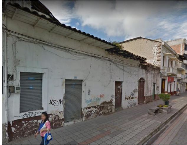
Figura 22.- Estado del inmueble antes de la intervención (Google Maps, 2014).
