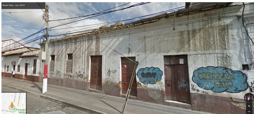
Figura 19.- Estado de los inmuebles antes de la intervención (Google Maps, 2014).
