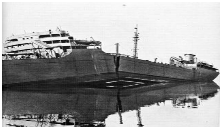
Figura 2.11 Falla de un barco por fractura
