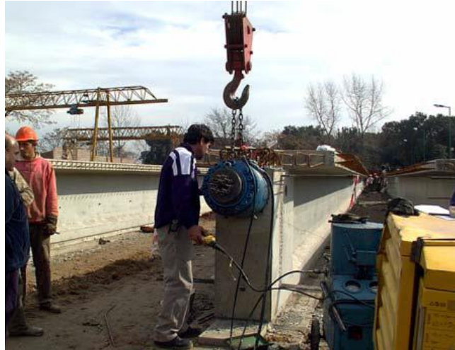
Fotografía 6.3 – Postensado de Vigas - Cruce Av. De La Serna sobre vías ex FC Roca – Avellaneda
