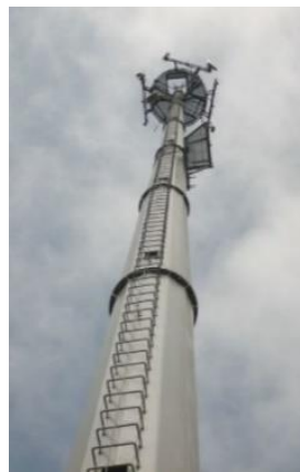
Figura 2.- Torre tipo monopolo [18]
