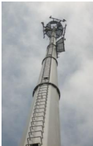
Figura 14.- Estructura tipo monopolo de secciones poligonales [18]
