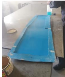
Aplicación de líquido desmoldante
