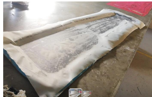
Aplicación de peel ply
