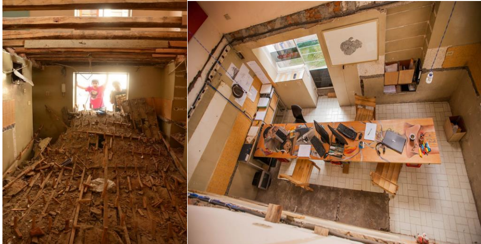
Imagen 4: “En Construcción”, (AlBorde, 2014)
