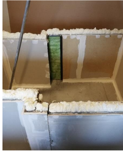
Colocación de espuma aislante en el interior de las paredes de la cámara.
