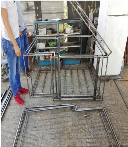
Armazón de estructura metálica de la cámara.
