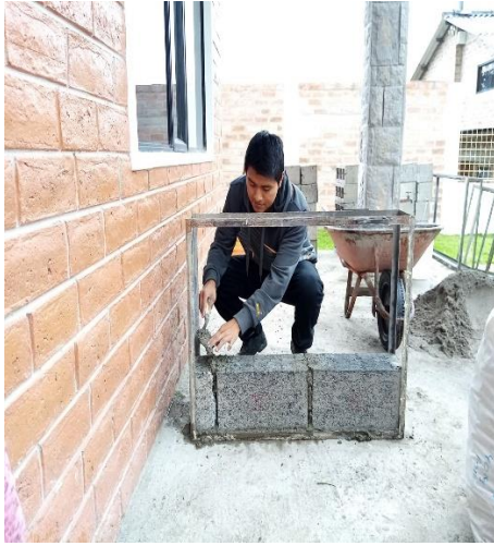
Elaboración de paredes.
