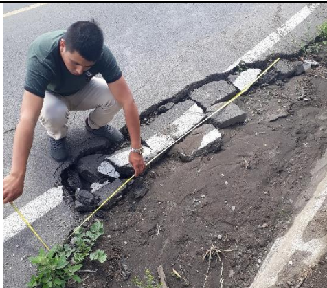
Toma de datos en las secciones más críticas vía.
