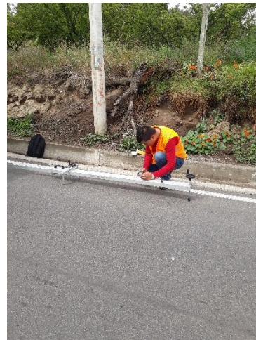
Realizar el armado de la viga Benkelman.
