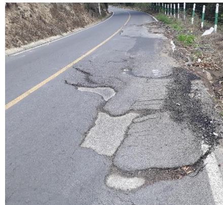
Toma de datos en las secciones más críticas vía.
