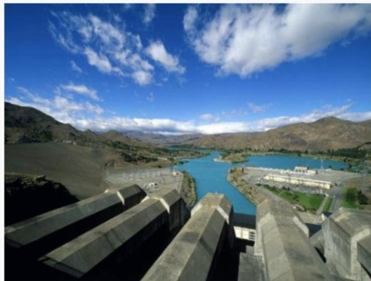
Figura 5. Vista aérea de una hidroeléctrica
