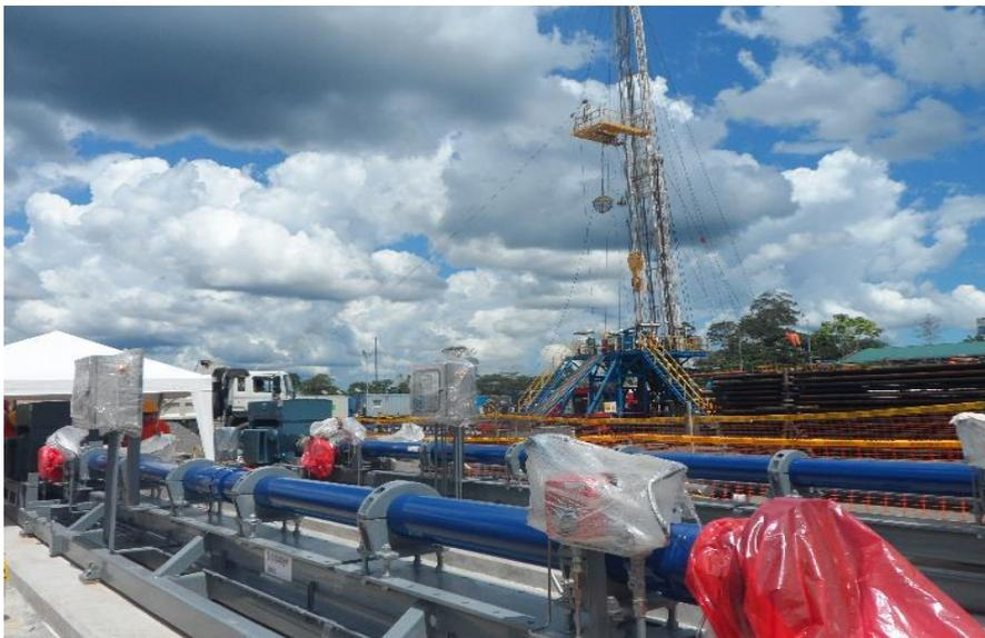
**Imagen 9:** Trabajos mecánicos para interconexión de bombas de transferencia.
