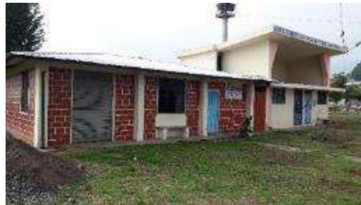
Imagen 24 Construcción junta de agua y casa bodega
