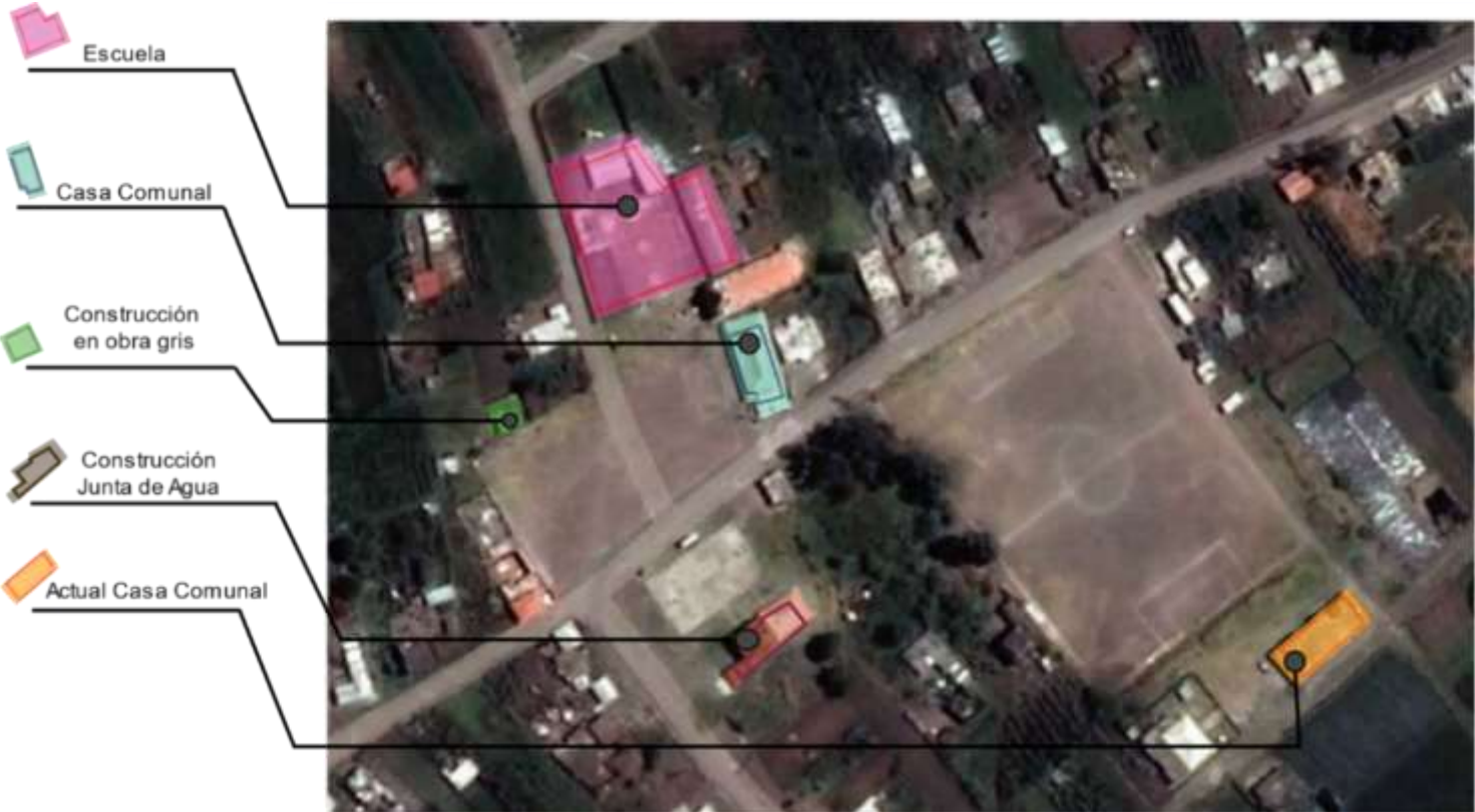
Imagen 28 Ubicación de construcciones comunitarias. Centro de comunidad Toallo Misquilli
