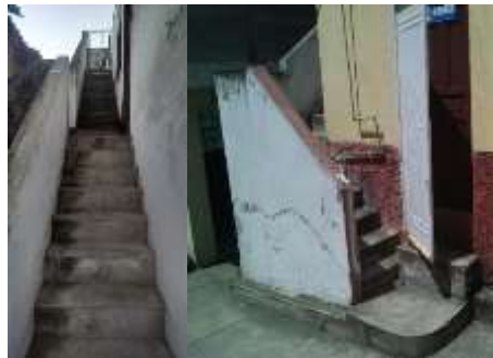
Imagen 21: Escalera externa de cemento - segunda edificación
