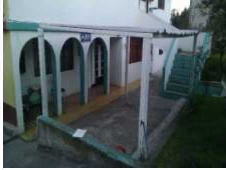
Imagen 8: Fachada de la edificación, perspectiva norte del Centro de Reposo Sagrado Corazón de Jesús
