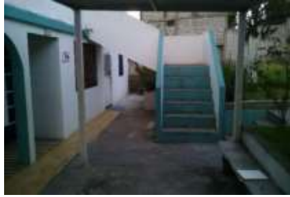
Imagen 14: Escaleras a segundo piso del Centro de Reposo Sagrado Corazón de Jesús
