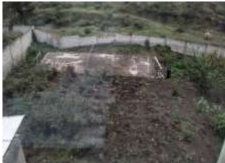
Imagen 30: Cancha deportiva deteriorada y vegetación sin mantenimiento
